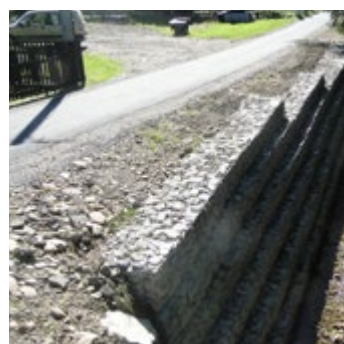
Odbudowa drogi gminnej ul. Rzeczna w Korbielowie
