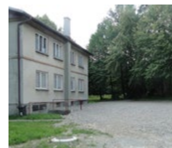
Utwardzenie terenu obok Ośrodka Zdrowia w Sopotni Małej
