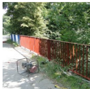
Remont barierki na moście w Sopotni Wielkiej
