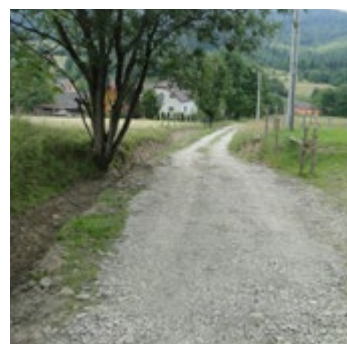
Częściowe utwardzenie wraz z odwodnieniem drogi „Pastorowy Potok” w Krzyżówkach
