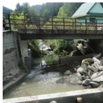
Odbudowa mostu w ciągu drogi „Na Mostach” w Korbielowie
