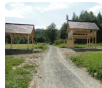
Kontynuacja robót związanych z budową ścieżek rowerowych w sołectwach Sopotnia Mała, Sopotnia Wielka, Krzyżówki, Przyborów
