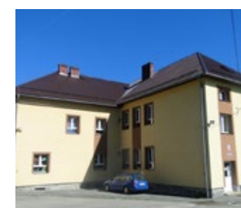
Remont dachu w Szkole Podstawowej nr 1 w Pewli Wielkiej
