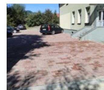
Wykonanie nawierzchni na parking przy Zespole Szkolno-Przedszkolnym w Pewli Wielkiej
