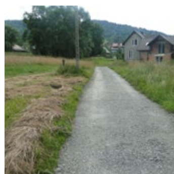
Utwardzenie drogi „Do Hankusa” w Sopotni Wielkiej
