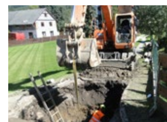
Budowa sieci wodno-kanalizacyjnej na terenie gminy Jelesnia
